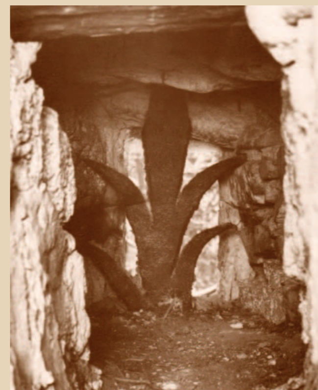
Fotografie, Der zwei Meter tiefe Luftschacht, bzw. das Fenster im Pilsacher Kerker mit dem charakteristischen Eisenblatt als Vergitterung
